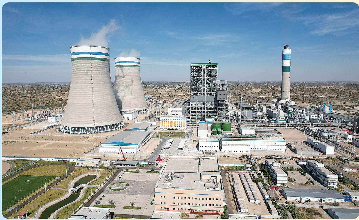
这是2月28日在巴基斯坦塔拉地区航拍的塔拉煤田一区块电一体化项目外景。
