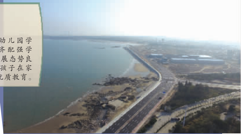
共富路等道路的建成串起海岸带景观画廊
