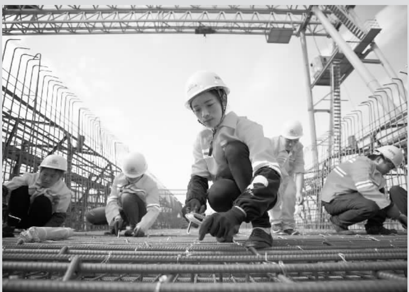
12月6日,在新建福厦铁路第8标段厦门同安制梁场,工人在绑扎梁体钢筋。当日,福建首条高速铁路——新建福厦铁路桥梁主体工程首孔箱梁顺利浇筑,标志着桥梁主体工程由下部结构向上部结构有序推进。新建福厦铁路是国家“一带一路”建设重点工程,铁路正线全长277.42公里,预计2022年建成通车。(新华)
