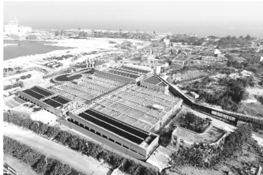
锦尚绿源污水处理厂启动加盖除臭改造项目
